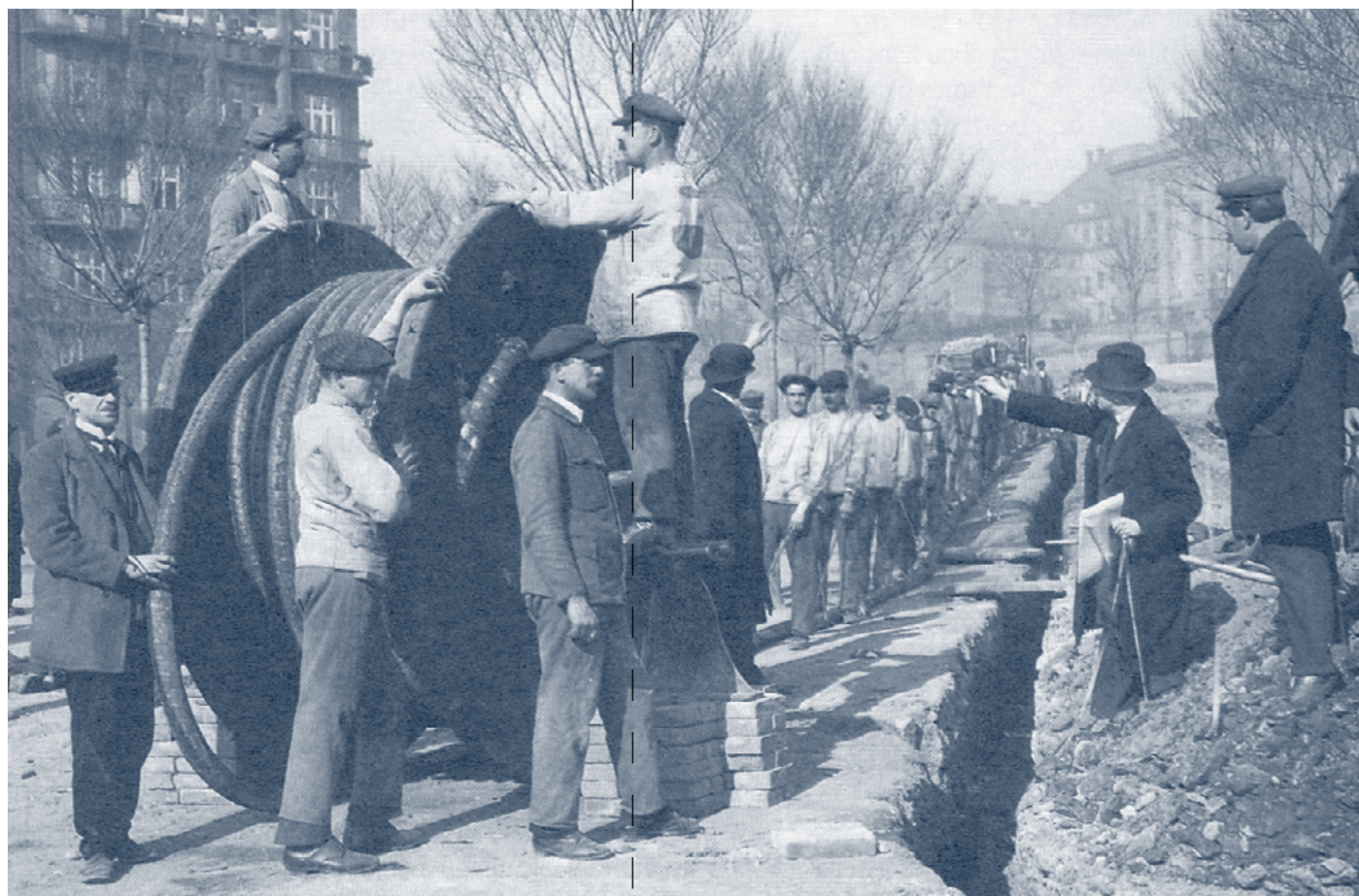
Pokládka kabelu vysokého napětí ve 20. letech 20. století.
