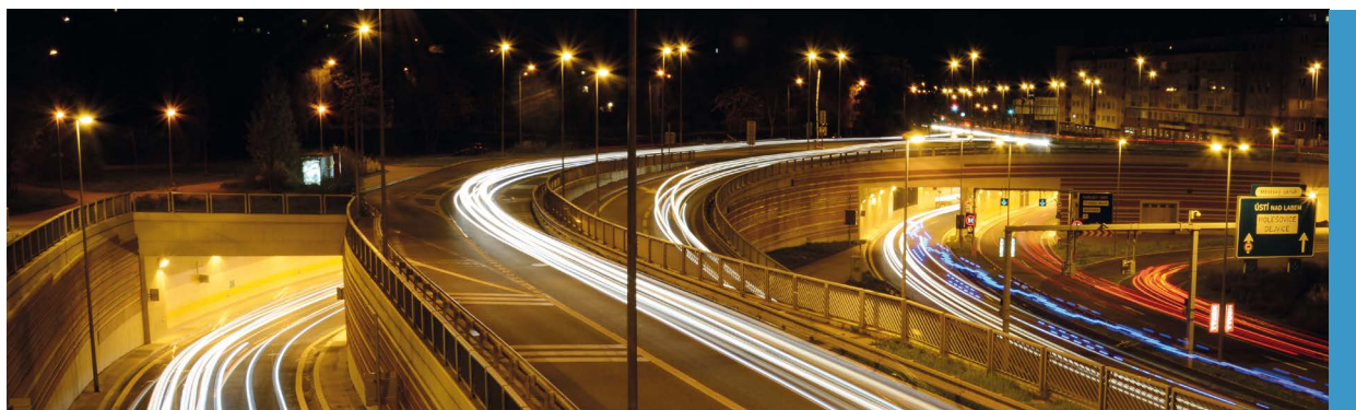
Více než čtyřicetí pražskými tunely denně proudí desetitisíce aut, tisíce chodců a stovky vlaků. Naše elektřina jim svítí na cestu, napájí zabezpečovací zařízení a přivádí čerstvý vzduch.
